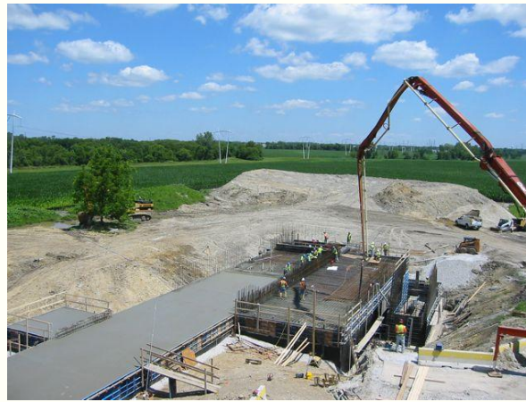
Pouring Concrete
