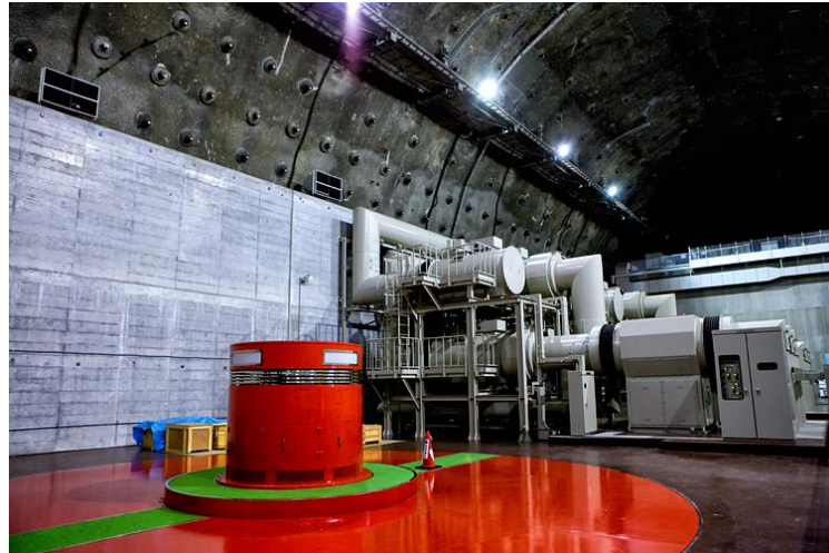
Kannagawa UPS Cavern
