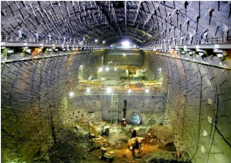
Kannagawa UPS Cavern
